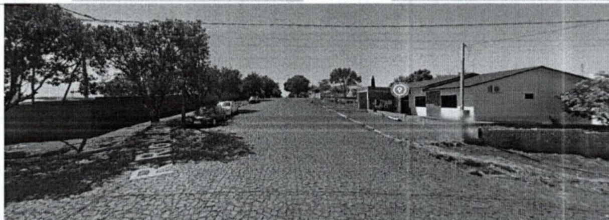
Começo da pavimentação. Estaca OPP. Esquina com Rua Tupinambás
